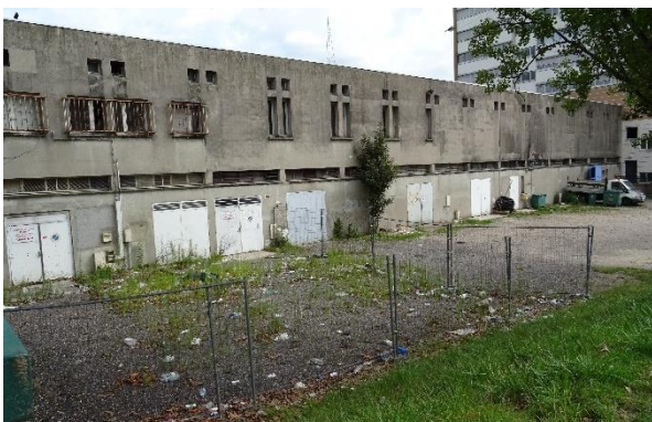
Façade arrière du bâtiment
