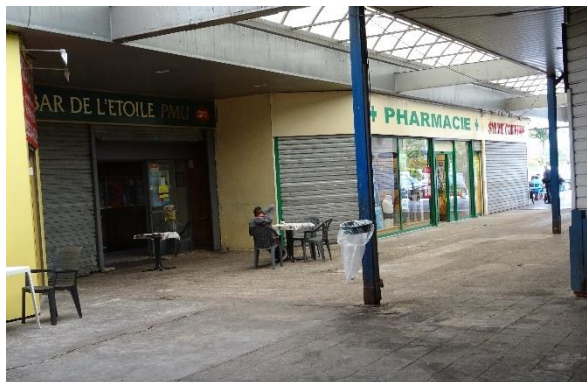
Enseignes et allées internes du centre commercial
