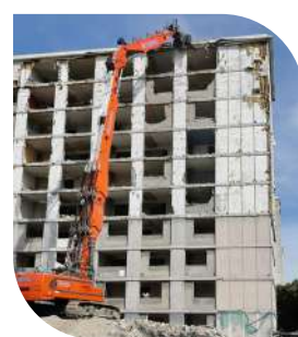
Déconstruction du bâtiment « Normandie » aux Provinces.
