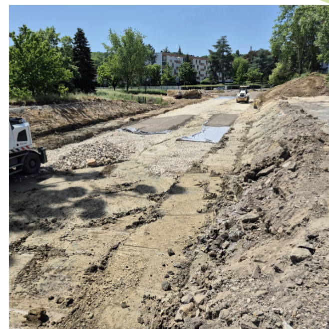
Le chantier au 29 mai 2026 Grand Nancy
