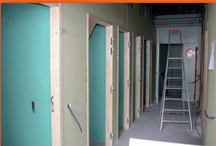
Réfection des vestiaires du Gymnase Louis Pergaud
