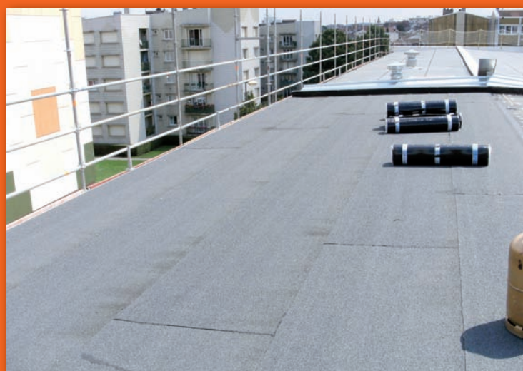
Site Pasteur Association Pour la Promotion et l'Enseignement de la Musique (APEM) : réfection de la toiture
