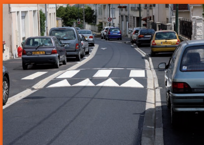
Fin des travaux de la rue de la République
