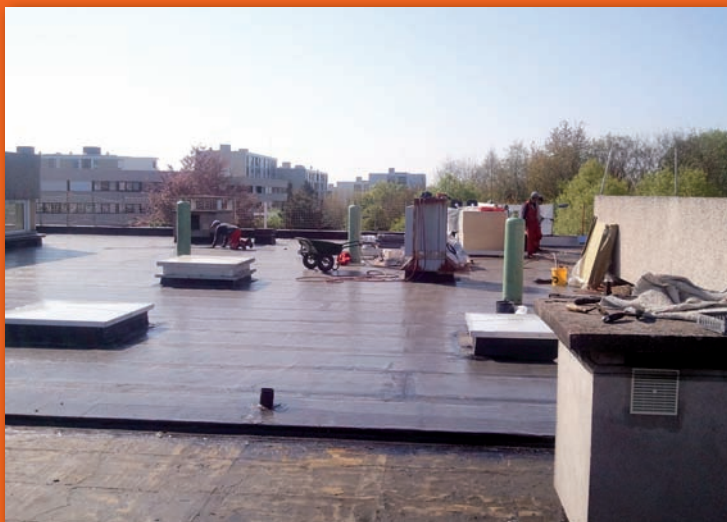
Centre Intercommunal Laxou-Maxéville (CILM) : réfection des toitures
