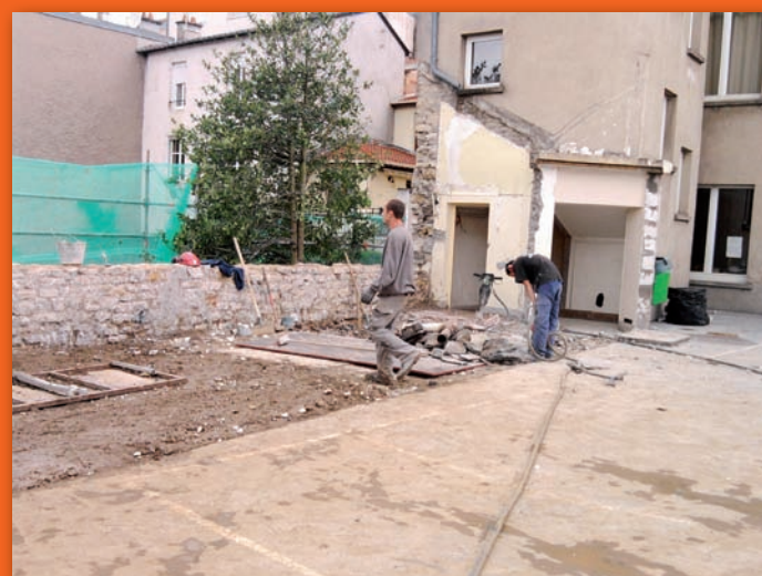
Travaux dans le Groupe Scolaire Louis Pergaud
