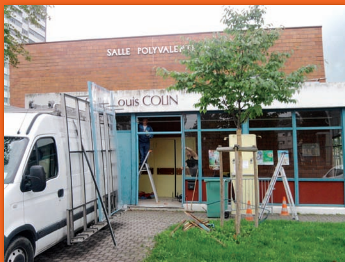
Mise aux normes de sécurité des portes de la salle Louis Colin
