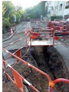
La première phase de travaux d'enfouissement de réseaux hydrauliques place du Jet d'eau et rue Edouard Grosjean est terminée. Les fosses qui permettront aux tilleuls de trouver l'alimentation nécessaire à une croissance satisfaisante sont préparées. Les pavés et les bordures doivent être repo-
