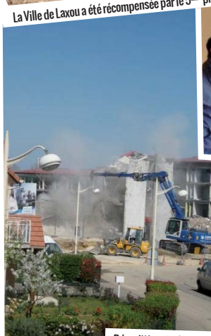
Démolition de Saint-Jo.
