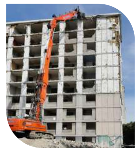
Déconstruction du bâtiment « Normandie » aux Provinces.
